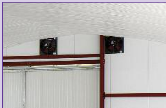
L'isolation du plafond de la nurserie est obtenue avec des panneaux isolants et un vide d'air. La seconde partie du bâtiment, qui accueille les veaux sevrés, est simplement isolé, car à ce stade ils sont moins fragiles.
